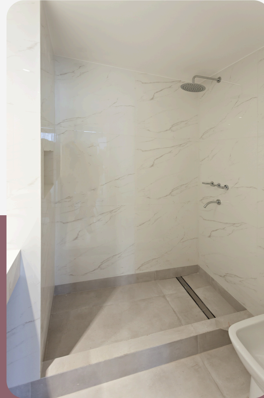
BAÑOS EN SUITE CON DUCHA WALK IN Y DESAGÜE LINEAL
